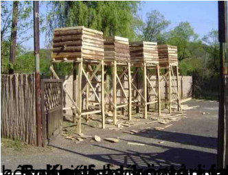
25. Képfelirás: A képen látható a fűrésztől a legelső lépésben a keret felépítése. A keret a szerkezet alapja, amelyre a további felépítés történik.
